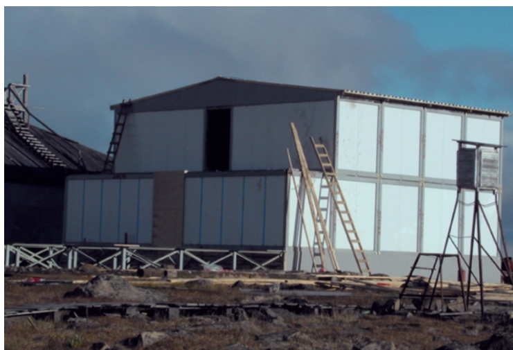
Строительство нового модульного служебного здания на ТДС Диксон
